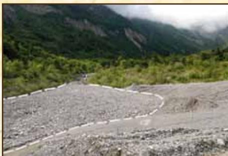
Étalement de la lave du 06/06/2010 dans la plage de dépôt (6 à 7 mètres d'accumulation de matériaux en amont)
