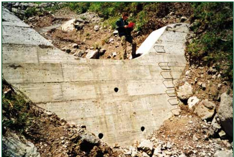
Des reconstructions d'ouvrages ont souvent été nécessaires. Ici le barrage 11 dans le ravin de Grosse Pierre reconstruit en béton armé en 2002. Originellement en pierre sèche il avait été détruit en 1996 par une lave torrentielle.
