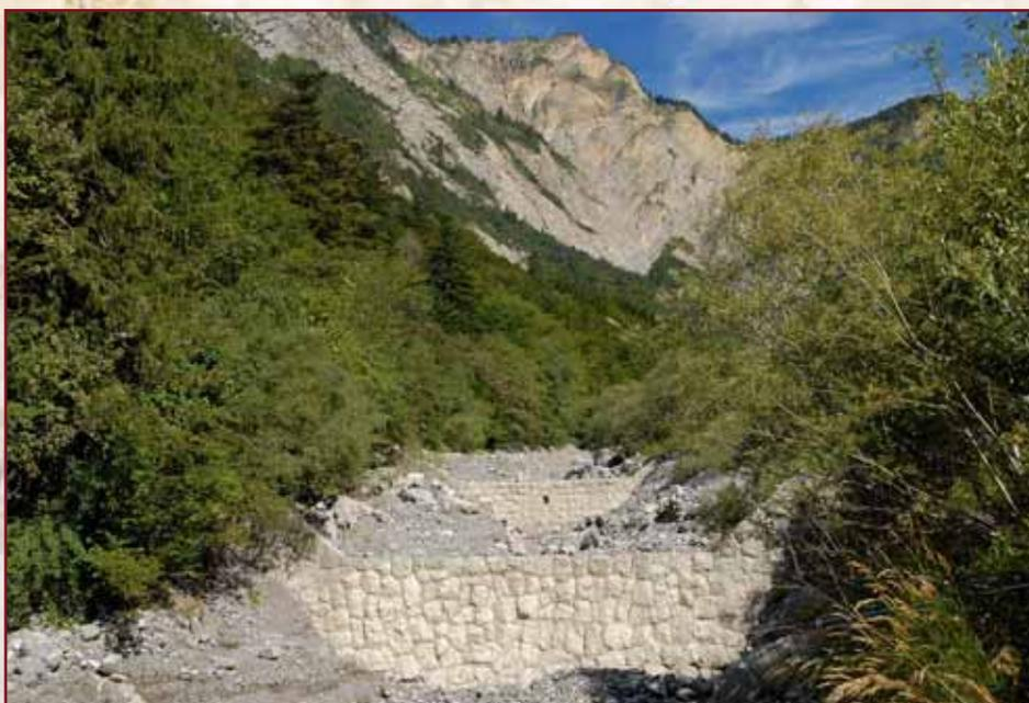
Barrage 46 et suivants (vers la cote 850 m) construits en pierres maçonnées en aval de la série historique.
