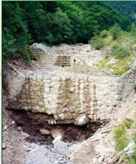
Affouillement d'un barrage en pierre maçonnerie
