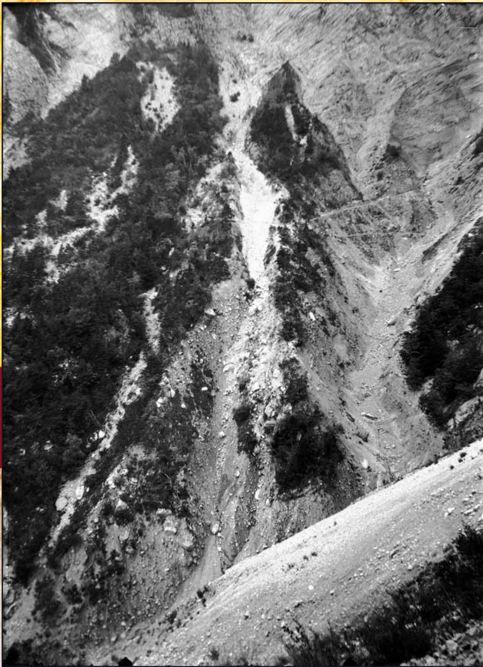
Mais il ne suffit pas seulement de construire ! Il fallait sans cesse retracer les sentiers, réparer les ouvrages après chaque crue (celle du 10 juillet 1902 ayant endommagé 29 barrages !), voire en reconstruire certains, etc. C'est ainsi que par exemple chaque ouvrage a fait en moyenne l'objet de 3 réparations entre 1895 et 1914, de 1,5 entre 1921 et 1940...
