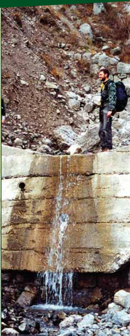
Affouillement d'un barrage en béton armé
