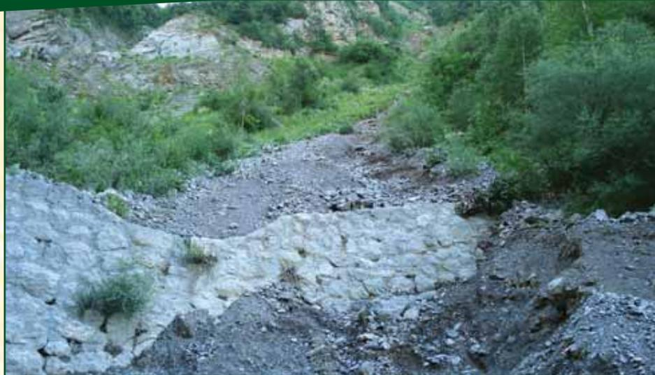
Vue sur la rive gauche, vers 945 m, montrant une activation modérée du ravinement au niveau des éboulis. Le contournement de la cuvette latérale du barrage B22 est à noter.
