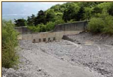
Barrage d'arrêt de la plage de dépôt le 07/06/2010 après le passage d'une petite lave
