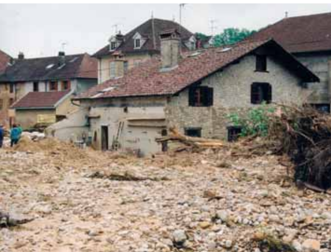
Crue torrentielle du ruisseau de la Cascade - St-Geoire-en-Valdaine (38) 7 juin 2002 © S. Gominet - IRMa
