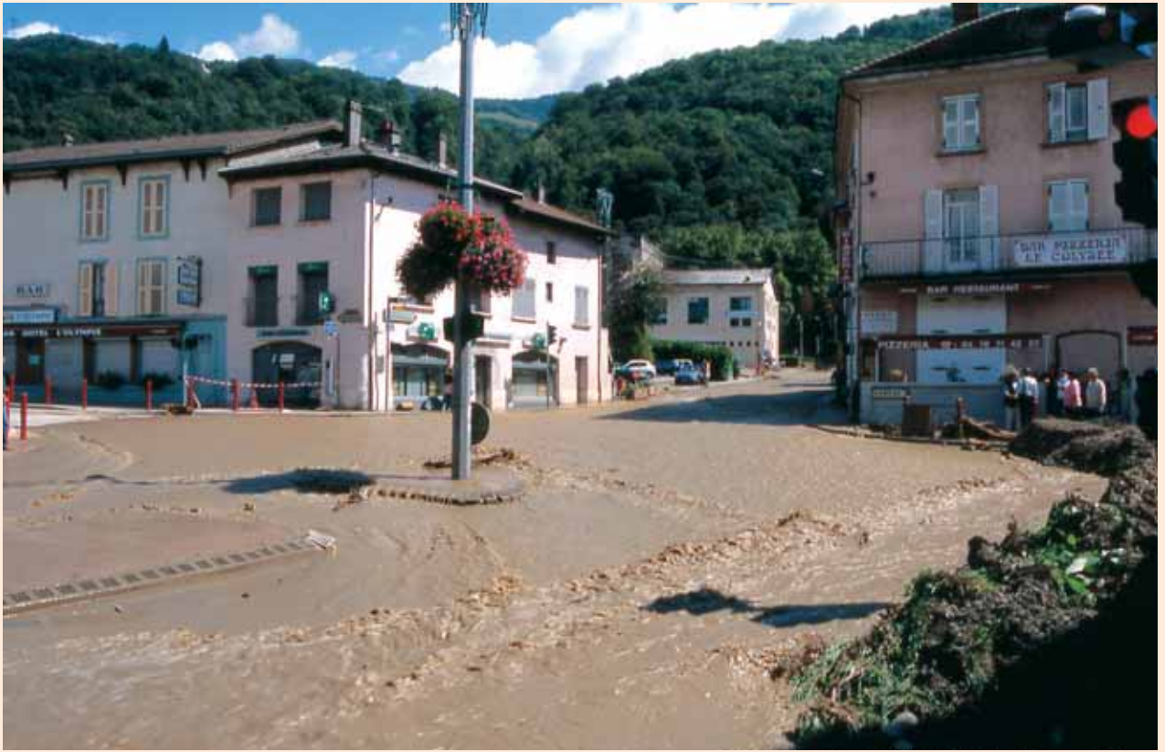
Carrefour RD165 et RD523 sur la commune de Villard-Bonnot (38). Le torrent de la Combe de Lancey est sorti de son lit après obstruction par les matériaux charriés de la galerie située sous les papeteries de Lancey 23 août 2005 © S. Gominet - IRMa
