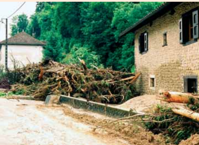
Embâcle au niveau du pont du ruisseau de la Cascade dans le hameau de la Gaité à Saint-Geoire-en-Valdaine (38) 6 juin 2002 © S. Gominet - IRMa
