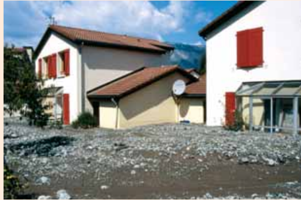
Engrèvement (environ 1 mètre) des terrains situés juste en aval de la rupture de la digue du torrent du Domeynon - Commune de Domène (38) 23 août 2005 © S. Gominet - IRMa
