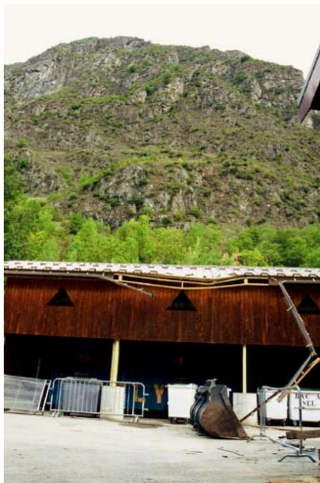
Le toit de cette déchetterie a été endommagé par un bloc qui est passé par dessus le merlon de protection construit quelques années auparavant.
