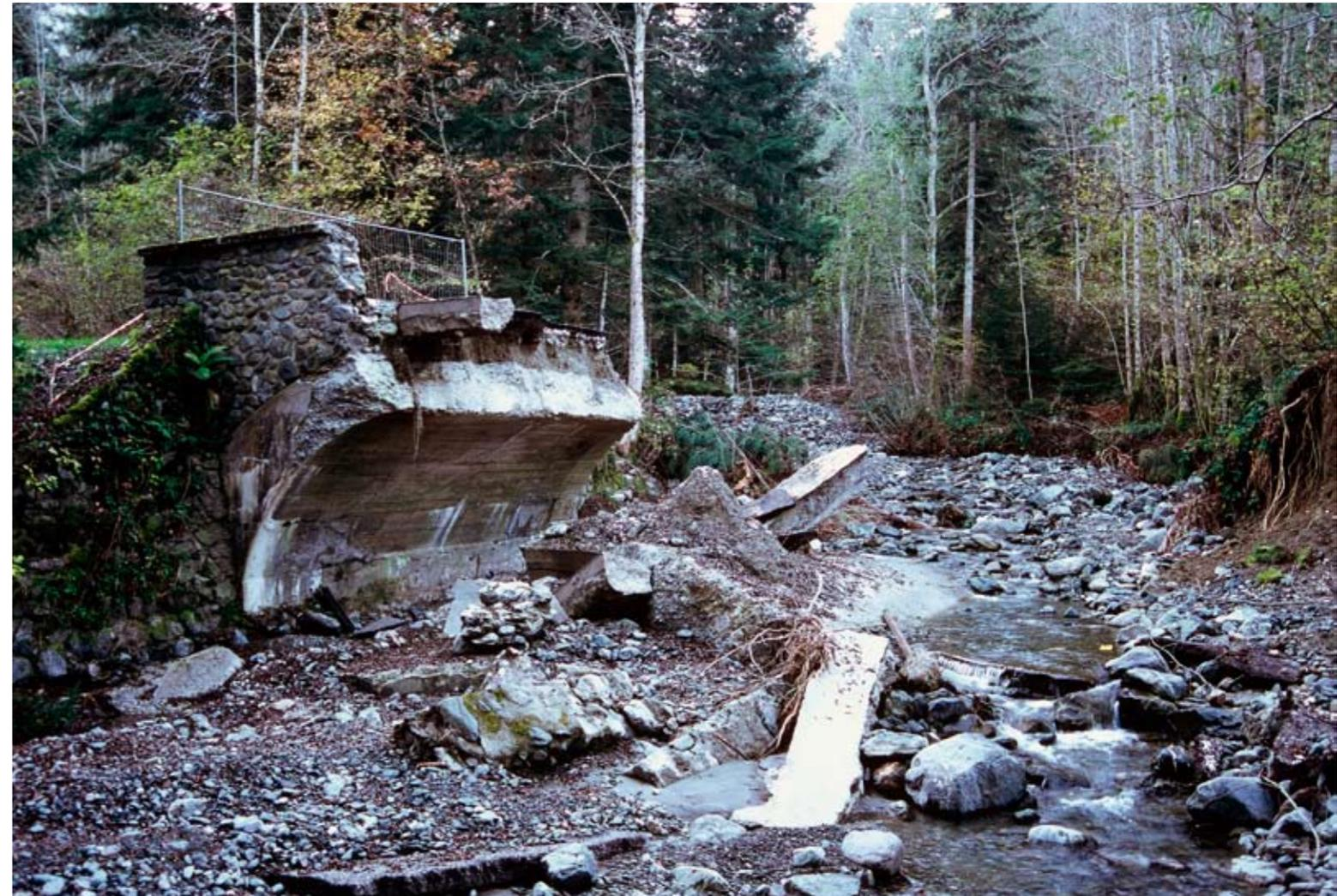
En amont de Domène, le torrent du Domeynon a aussi causé de nombreux dégâts, liés essentiellement à la force du courant et à l'érosion des berges. Ici, la destruction du pont de la route départementale 280.
