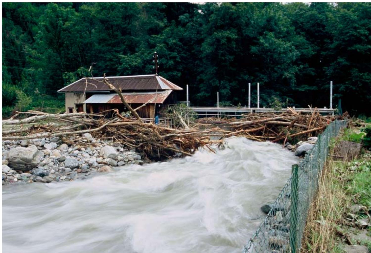
Erosion des berges du Bréda et accumulation de bois morts transportés par la crue en amont de l'usine hydro-électrique de la commune de la Ferrière d'Allevard.
