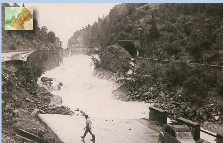
Chaussée effondrée vers Saint-Michel-de-Maurienne au cours de la crue torrentielle de l'Arc en 1957
