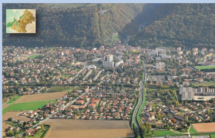
Le torrent du Doménon traverse le centre ville de Domène en souterrain. A sa sortie, il est entièrement endigué
