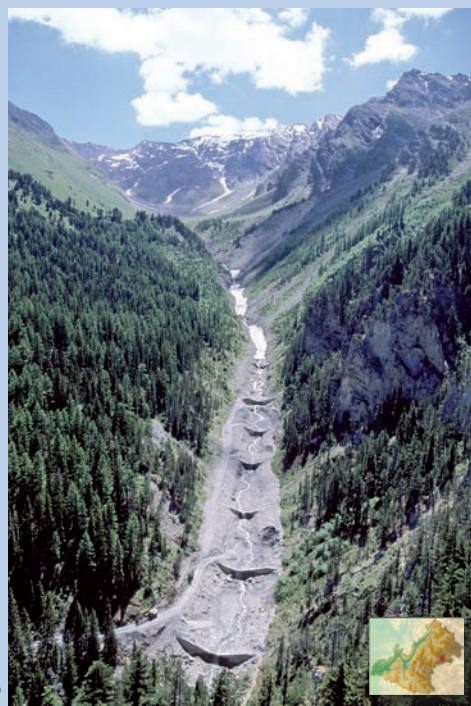
Barrages dans le lit du Saint-Antoine à Modane
