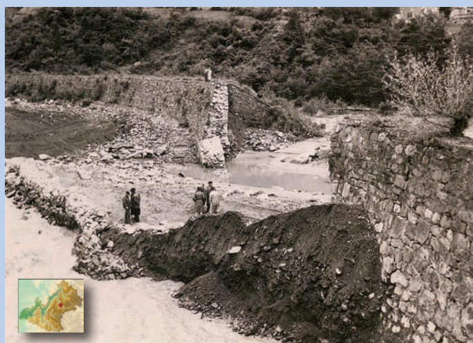
En 1957, l'Arc a ouvert une brèche dans la digue de Villargondran derrière laquelle la plupart des maisons ont été emportées ou détruites
