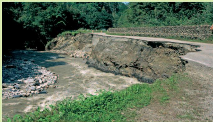
Erosion de la berge du Bréda : écroulement de la RD 209 sur la commune de la Chapelle du Bard.
