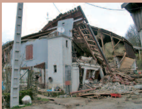
Vieille bâtisse effondrée à la suite du glissement.
