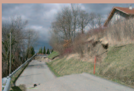
Fissure de tête du glissement de Vougron. Décrochement de 1,50 à 1,80 m affectant notamment la RD121 sur 60 m.
