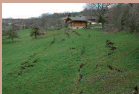
Arrachements des terrains dans un champ liés au glissement.
