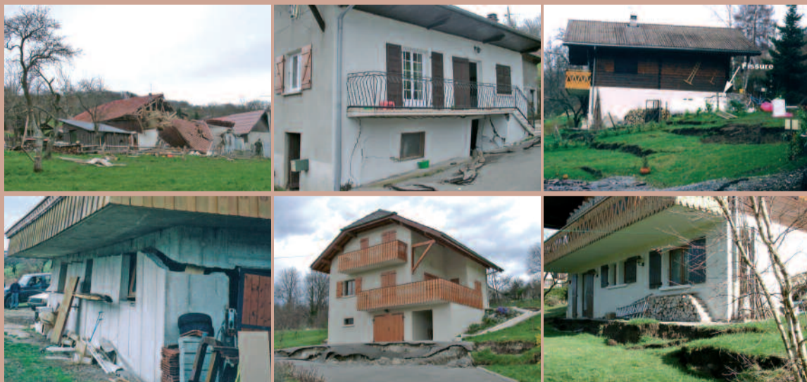
Dégâts aux habitations des hameaux «Chez Grobel» et «Chez Truffaz» après le glissement de mars 2001
