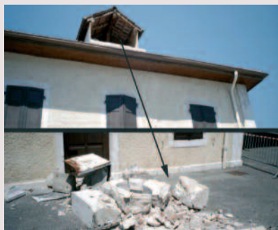
Dégâts à la crèche municipale de Metz-Tessy, Haute-Savoie.
