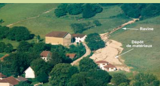
Cormérieu - coteau des Balmettes. Ravinement dans une combe en crue. Engravement des terrains alentours et de la voie communale.
