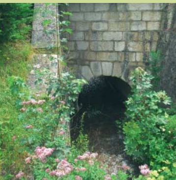
Le remplacement du pont de la Gaîté (classé en priorité 2), par un ouvrage permettant le transit de la crue centennale, n'est toujours pas réalisé. Le barrage d'arrêt et la plage de dépôt (classés en priorité 1) ont en revanche été réalisés en amont du hameau de la Gaîté. Ils sont destinés à retenir les matériaux transportés par le ruisseau de la Cascade.
