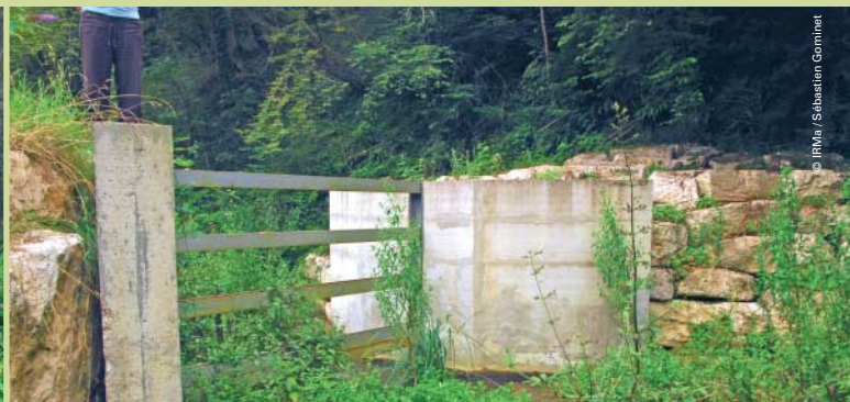
Le remplacement du pont de la Gaîté (classé en priorité 2), par un ouvrage permettant le transit de la crue centennale, n'est toujours pas réalisé. Le barrage d'arrêt et la plage de dépôt (classés en priorité 1) ont en revanche été réalisés en amont du hameau de la Gaîté. Ils sont destinés à retenir les matériaux transportés par le ruisseau de la Cascade.
