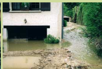
Le ruisseau de Saint Geoire a divagué dans une partie du bourg éloignée de son lit mineur (il est busé dans la traversée du centre) et située, à priori, à l'écart du champ d'inondation. Un mur de soutènement a été détruit et plusieurs habitations ont été inondées et engravées (sur près d'un mètre de hauteur par endroits).
