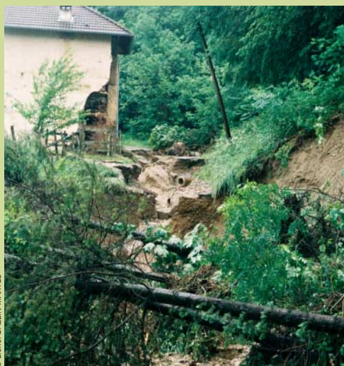
Habitation endommagée à la suite de phénomènes de ravinement (hameau de la Pale).
