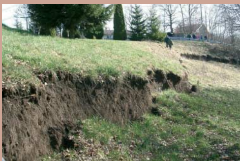
Niche d'arrachement sommitale du glissement vers Vougron (dans sa partie Nord-Ouest).
