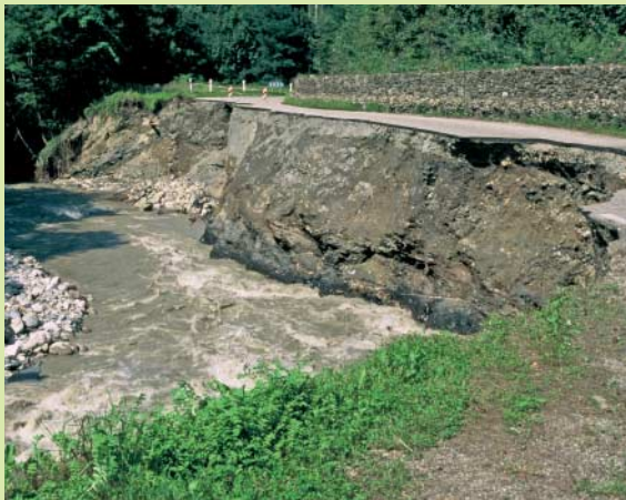
Erosion de la berge du Bréda : écroulement de la RD 209 sur la commune de la Chapelle du Bard.
