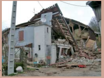
© RTM 74 Vieille bâtisse effondrée à la suite du glissement
