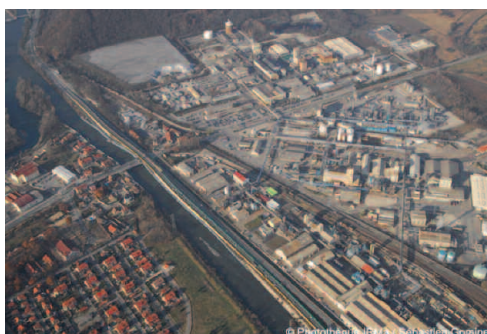
Vue aérienne du site industriel de Jarrie (38).
