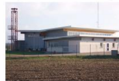
Centre de Secours
