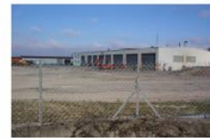
Centre d'équipements de la DDE
