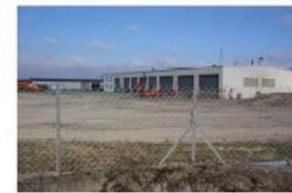
Centre d'équipements de la DDE
