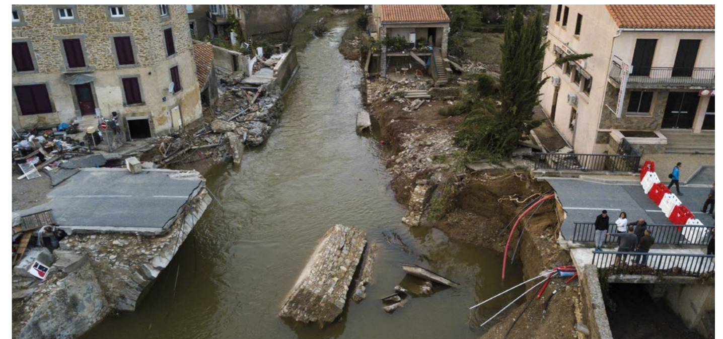
Pont de Villegailhenc détruit par la crue d'octobre 2018 © IRMa, Sébastien GOMINET, 2018
