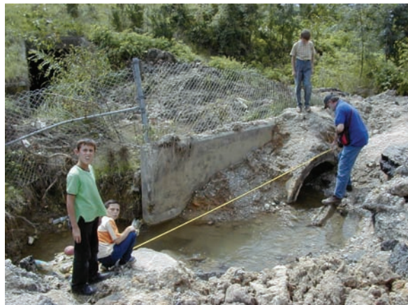
Figure 39 - Aléa, vulnérabilité, risque : Séisme d'Izmit (Turquie), 1999 : décalage horizontal (décrochant dextre) avec un rejet de 3,7 m de la canalisation rompue (Photo P. Mouroux, BRGM)
