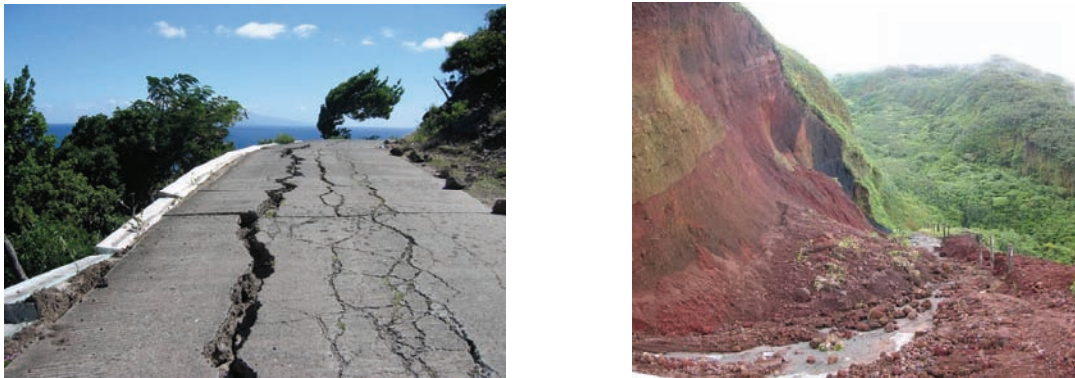
Figure 35 - Aléa, vulnérabilité, risque : Exemple de mouvements de terrain déclenchés par la vibration ismique : archipel guadeloupéen (Antilles) après le séisme du 21 novembre 2004 (photos S. Bès de Berc, BRGM)
