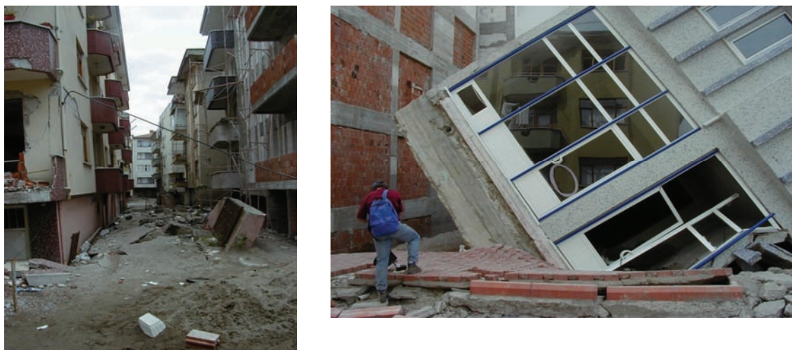
Figure 33 - Aléa, vulnérabilité, risque : Séisme d'Izmit (Turquie, 1999), Ville d'Apazari : rue recouverte par le sable remonté du sous-sol lors du séisme et bâtiment basculé du fait de la liquéfaction du sol (Photo BRGM, P. Mouroux)
