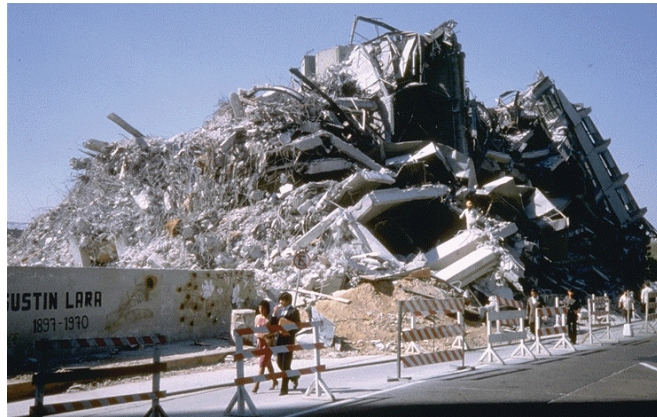
Figure 30 - Aléa, vulnérabilité, risque : Effet de site lithologique, Vue d'un immeuble de deux étages totalement détruits à Mexico en 1985 (@Cdt Fabre- Sécurité civile d'Avignon)
