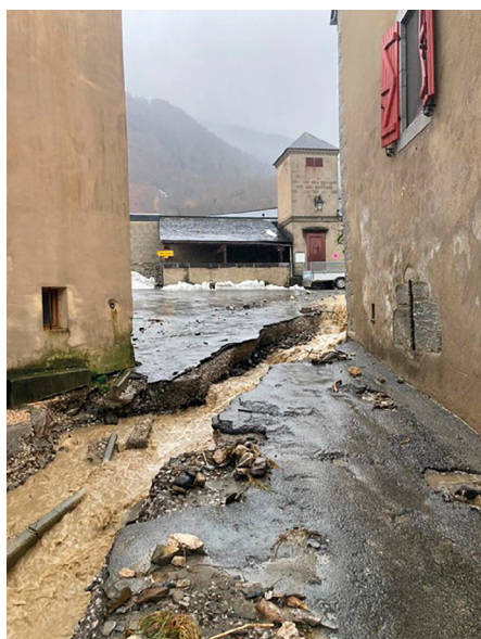
Centre-bourg de Laruns, crue de décembre 2021 - © Sdis
