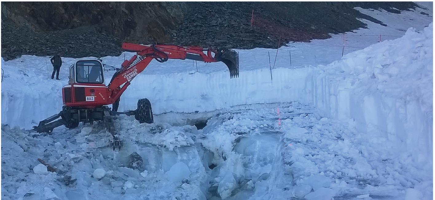
*Creusement de la crevasse existante, la seule, rive droite, afin de faciliter la sortie de l'eau et d'abaisser la pression existante dans la cavité ; rappelons la situation particulière de ce glacier qui ne dispose pas d'exutoire, et pire, dont le manteau de surface est en glace tempérée, laquelle laisse l'eau percoler et remplir une cavité qui est formée par le front glacière, qui lui est en glace froide - © ONF/RTM 74*
