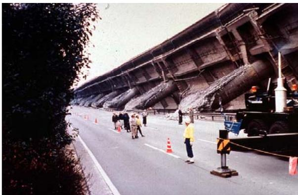
Photo A : la ruine d'un pont lors du séisme de Kobé par effet de pendule inversé
