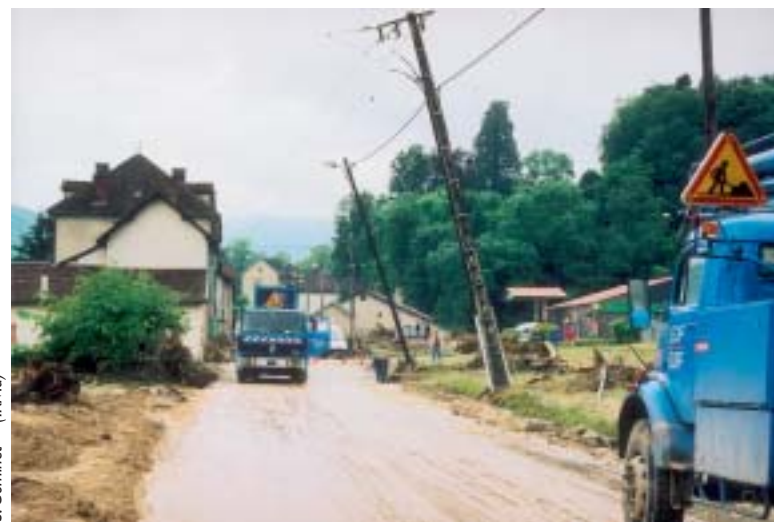
Pilons EDF couchés par une crue Saint-Geoire-en-Valdaine (38) - Juin 2002
