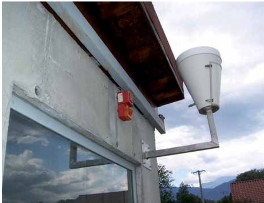
© L. Cassagne (IRMA) - Pluviomètre et alarmes, sonore et visuelle, mis en place au niveau des bassins de rétention. Les alarmes se déclenchent dès lors que l'eau pénètre dans le bassin, les riverains sont ainsi alertés (Eybens, 38)
