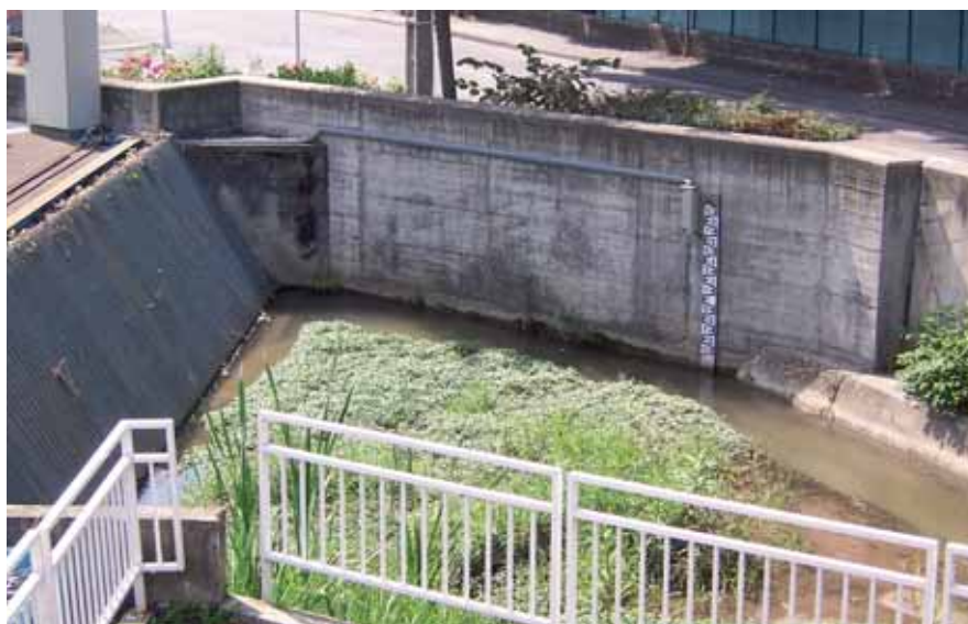
© L. Cassagne (IRMa) - sonde permettant l'alerte de l'astreinte, elle est située au niveau du dégrilleur (Eybens, 38)
