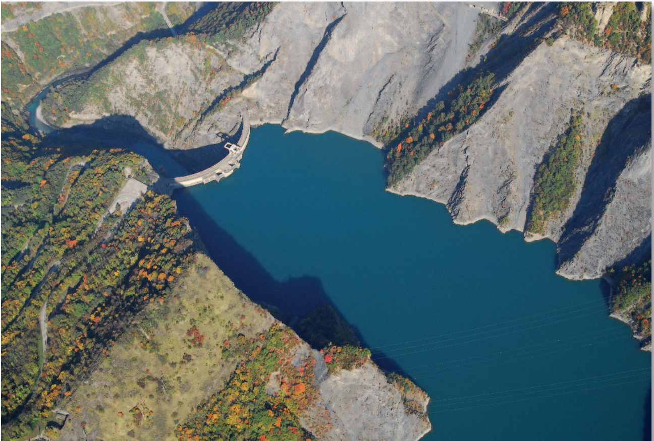
Barrage de Saint Pierre de Cognet (Isère) / © IRMA
