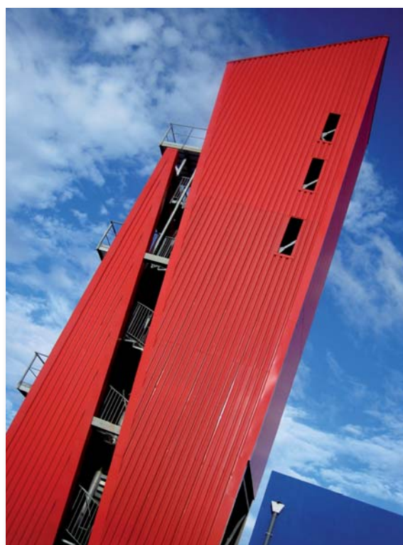
Etat-major du SDIS de Guadeloupe reconstruit aux normes parasismiques © Vincent Courtray, MEDDTL
