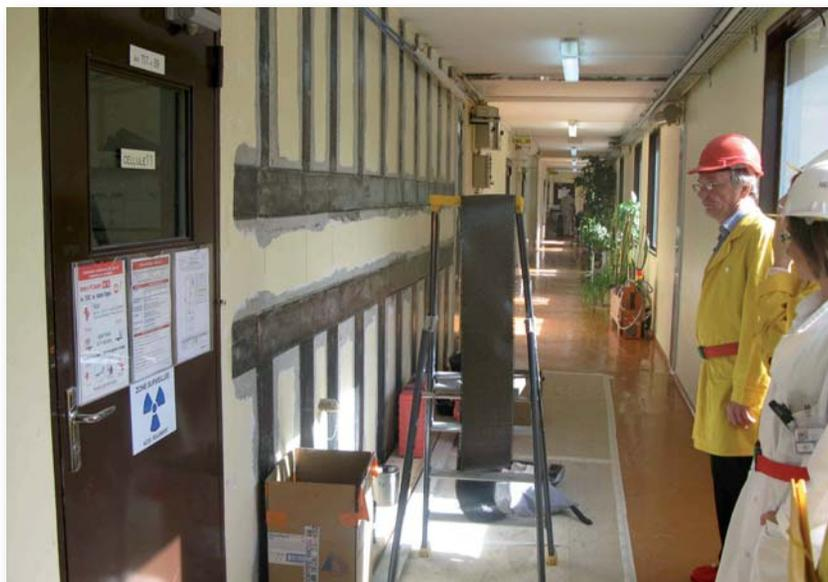
Figure 1 - Pose de bandes de fibres de carbone dans l'installation Lefca © asn
