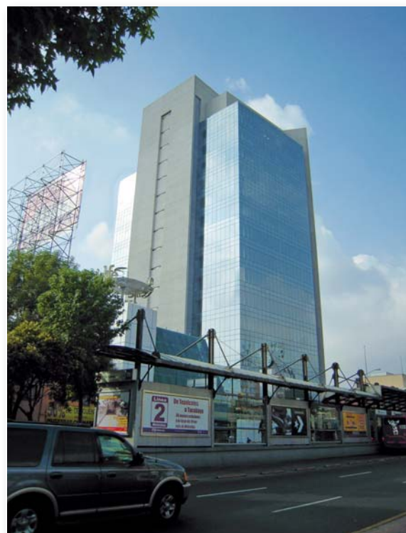
Le bâtiment étudié © Bureau Veritas
