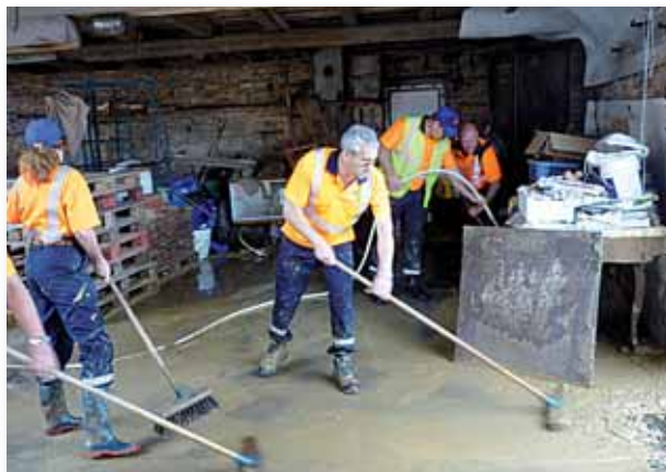
Nettoyage de maisons suite à inondations © mairie de Brumath
