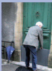
Pose de batardeaux et clapet anti-retour
