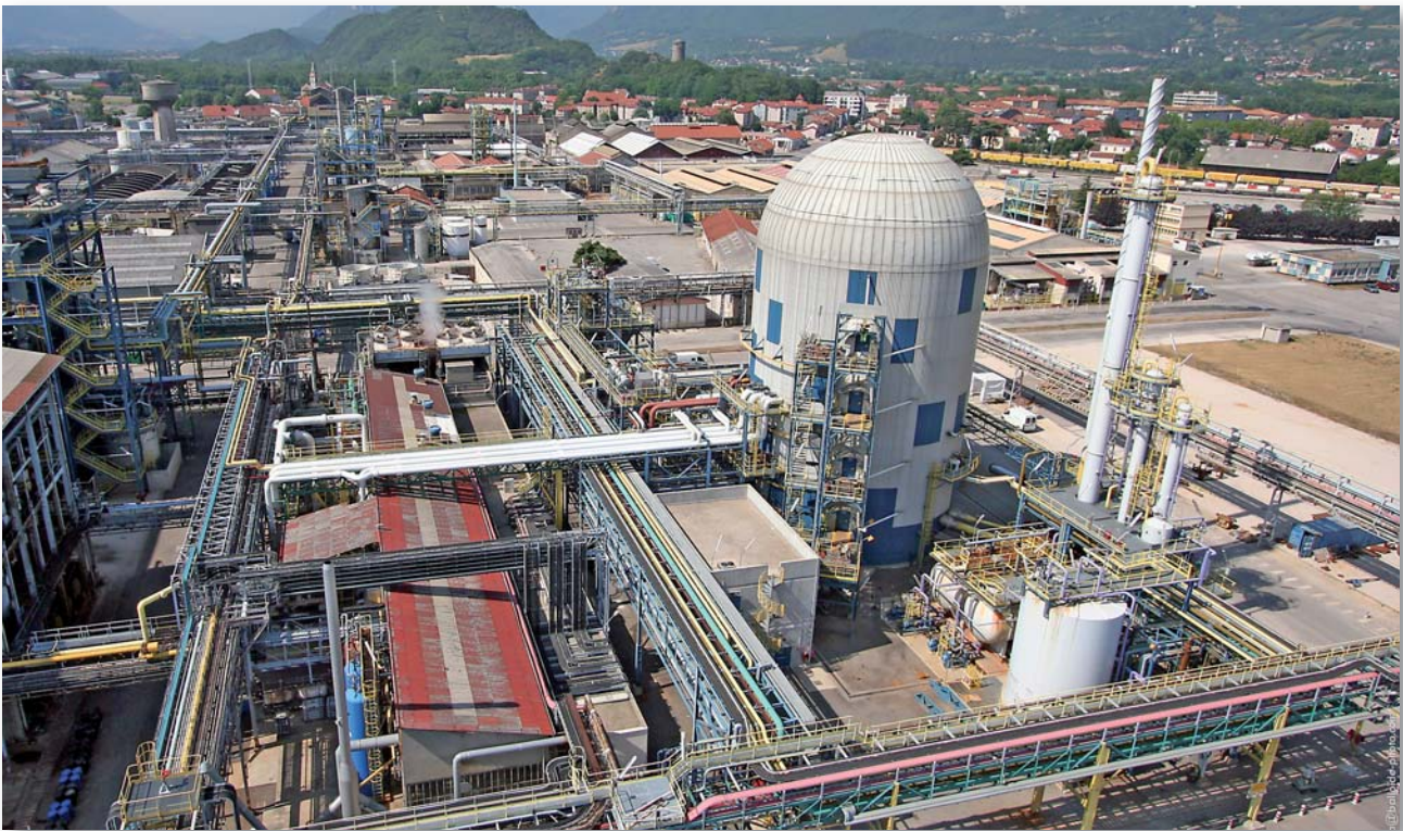
Plateforme chimique du Pont de Claix © BALLOIDE - photo.com
