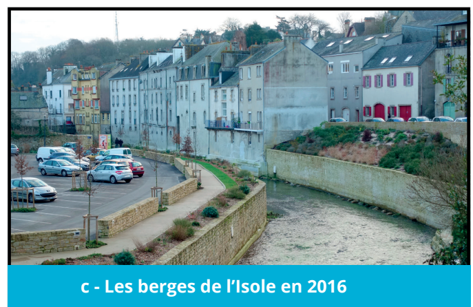
La commune de Quimperlé sensibilisée par la récurrence des inondations - a) Identification des crues majeures de la Laïta depuis 1970 ; b et c) Réaménagement des berges de l'Isole suite aux crues des 2013/2014 © ville de Quimperlé.
