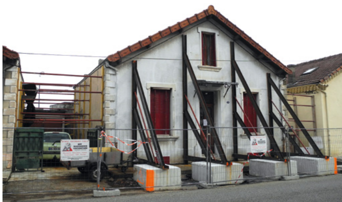
Étaieement d'une maison avenue Paul Langevin. © Photo Marc Givry, architecte
