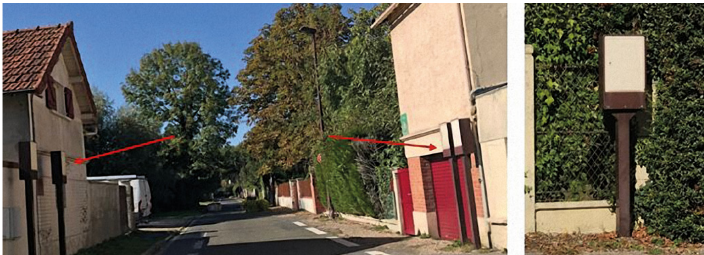
Photo 3: Armoires électriques surélevées à Jouy-le-Moutier (95) - © Varesano Lenzi, 2018.
