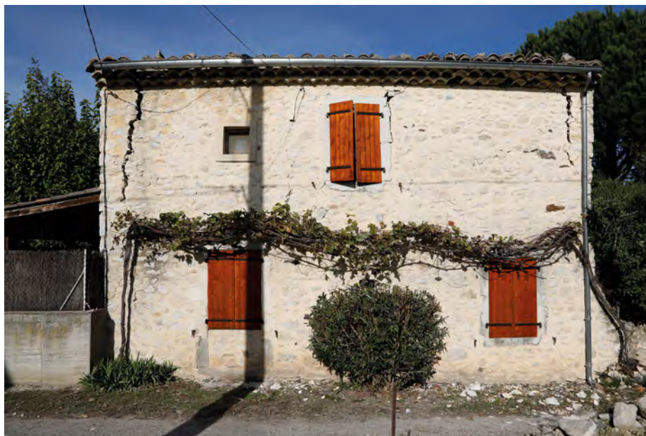
Séisme du Teil : habitation endommagée à La Rouvière © IRMa - Sébastien Gominet
