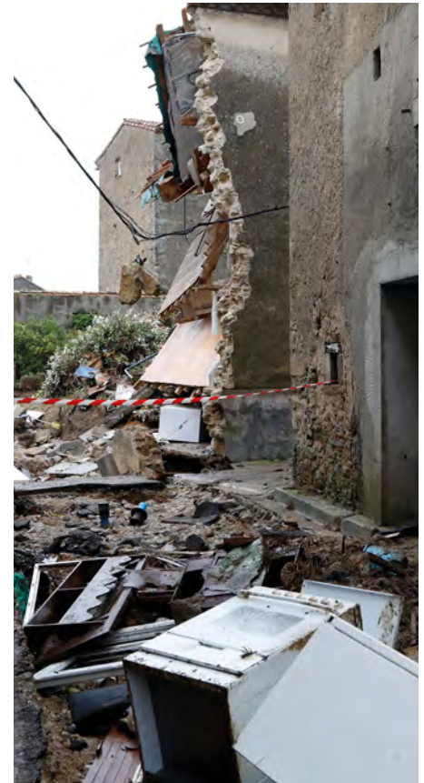
Inondations à Villegailhenc le 15 octobre 2018 - Dégâts rue de la mairie © Sébastien Gominet - IRMA
