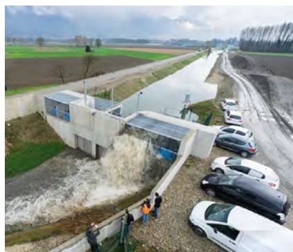
Essai sur la station de Cheminade - 2017 © SYMBHI / PHOTEC
