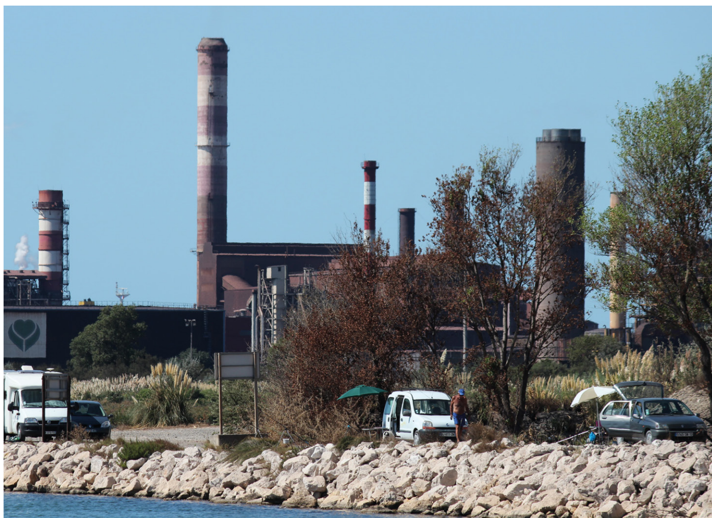
Site de l'usine ArcelorMittal Méditerranée - Fos-sur-mer - © Institut Ecocitoyen.
