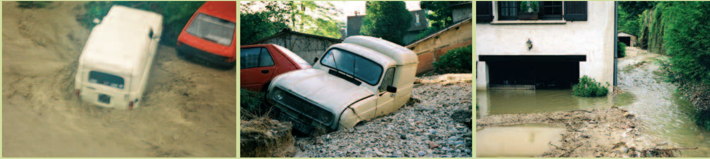
Le ruisseau de Saint Geoire a divagué dans une partie du bourg éloignée de son lit mineur (il est busé dans la traversée du centre) et située, à priori, à l’écart du champ d’inondation. Un mur de soutènement a été détruit et plusieurs habitations ont été inondées et engravées (sur près d’un mètre de hauteur par endroits).
