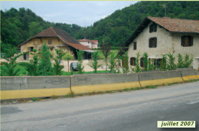
L’embâcle du pont de la Gaîté vu de l’aval (accumulation de bois morts)
