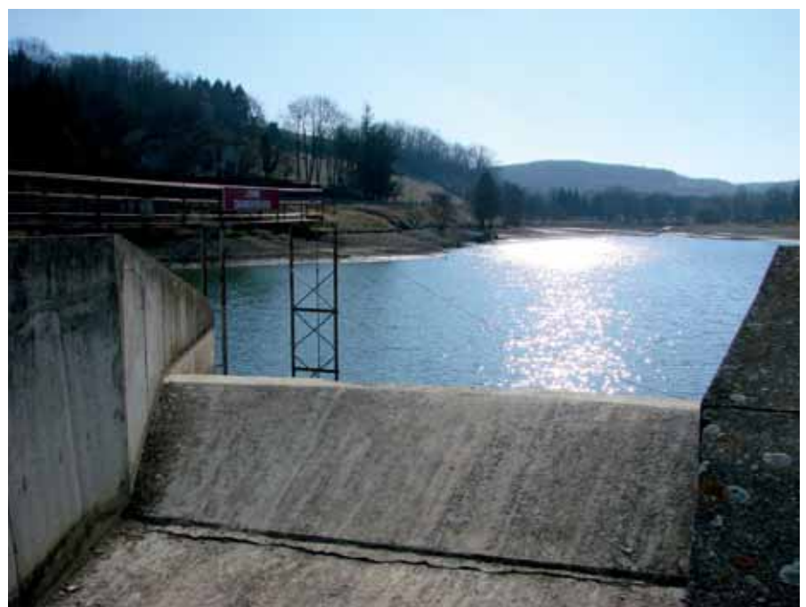
Barrage de Roybon - IRMa
