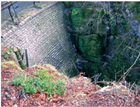
Barrage de La Balme de Rencurel
