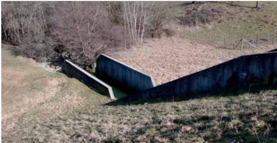
Evacuateur de crues du barrage de Roybon - IRMA
