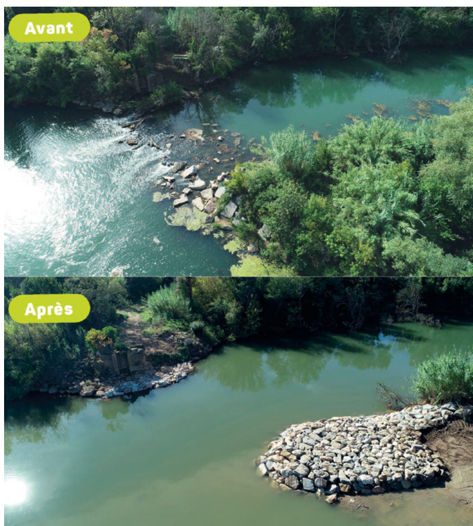
Travaux de suppression du seuil du moulin des Iscles à Roquebrune-sur-Argens – 2020 @SMA
