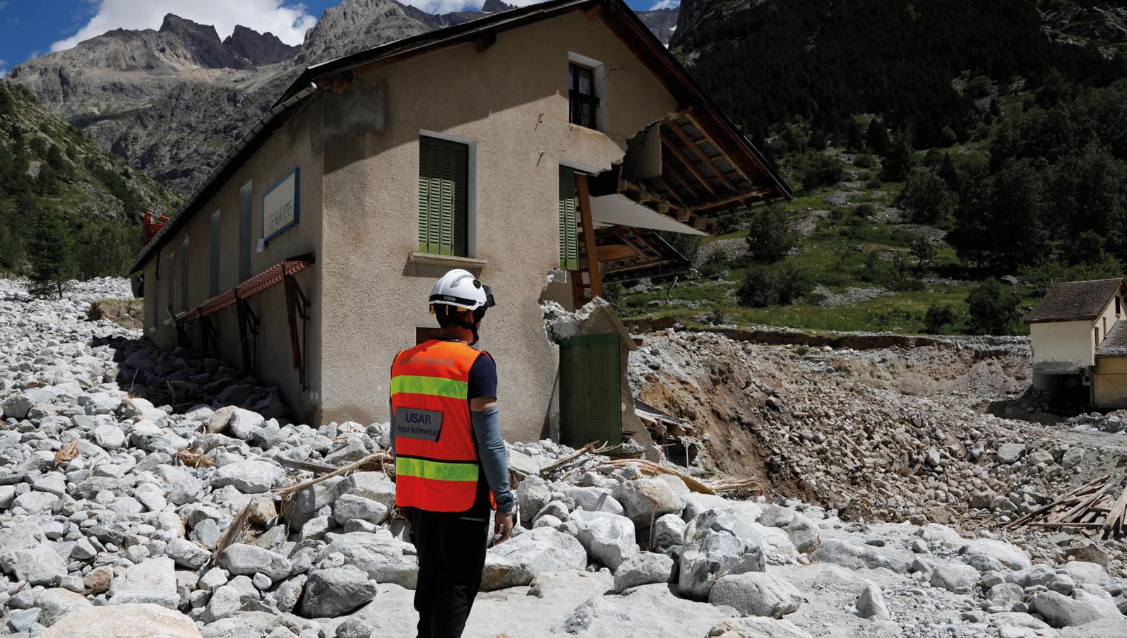
Le travail de l'unité de sauvetage d'appui et de recherche (USAR) du SDIS 38, a permis dès la fin de la crue, de classer les bâtiments en quatre catégories (échelle de dommages), afin de déterminer les risques d'effondrement de certains d'entre eux et de savoir s'il serait possible ou non pour les habitants de revenir chercher une partie de leurs biens.
