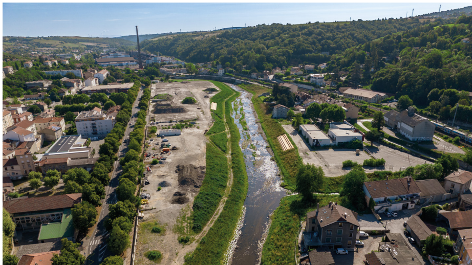
Le Gier au droit de l'ancienne verrerie à Rive-de-Gier après l'aménagement - ©SEM
