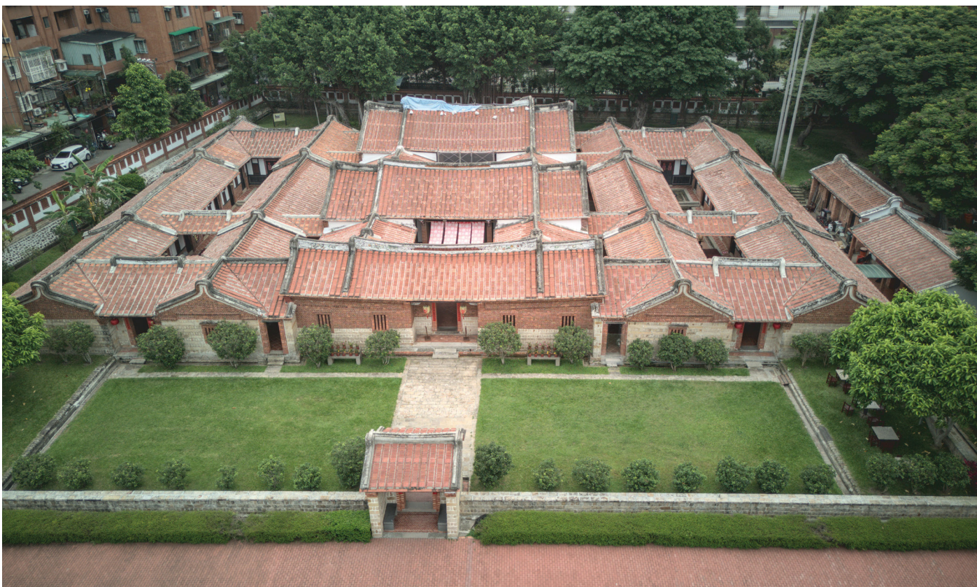
La résilience du patrimoine en question suite au séisme du 3 avril 2024 de Hualien à Taiwan © AFPS
